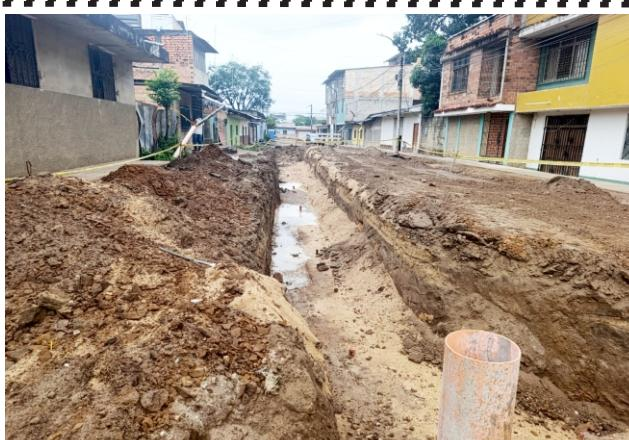
bución en una longitud de 50 metros aproximadamente, incluyendo las conexiones domiciliarias, esto con la finalidad de ejecutar la construcción de alcantarillas pluviales. Por lo que se procedió al cierre de la válvula de control en la intersección de los jirones Ramón Castilla y Libertad, afectando con el corte intempestivo del servicio a los siguientes sectores:
