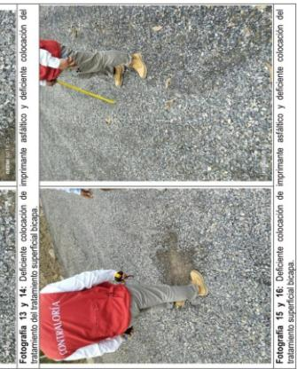
Fotografía 13 y 14: Deficiente colocación de impermeante asfáltico y deficiente colocación del instrumento de trabajo en superficie de tierra.
