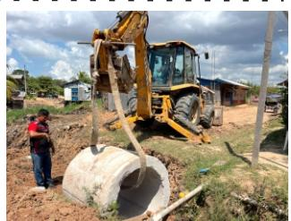
lio con trabajos de limpieza de la superficie de rodadura, bacheo, perfilado, compactado, llenado y, en este caso, la colocación de once tubos en dos intersecciones de caños naturales para mejorar el drenaje y la transitabilidad.
