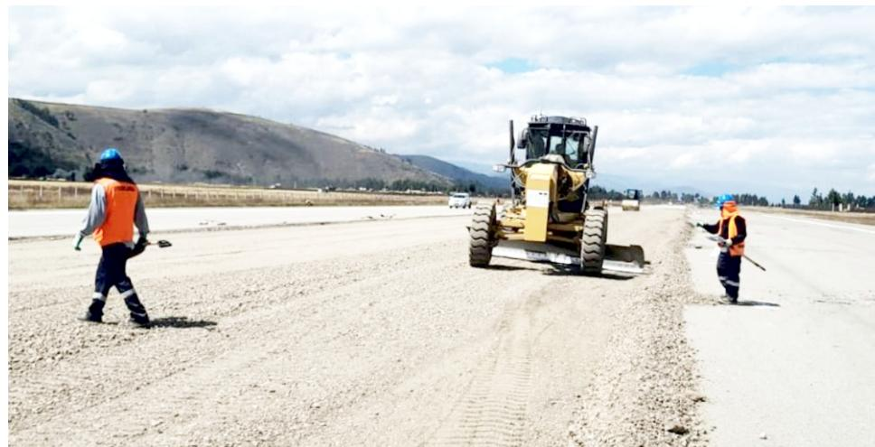
permitirá un descenso seguro y eficiente de los pasajeros", detalló Corpac. Área de maniobras críticas En la zona de viraje de aeronaves se retiró la carpeta asfáltica y se proyecta la instalación de una base estabilizada de 20 centímetros de es-
