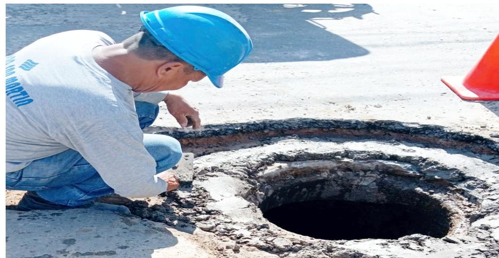
San Martín realizó la reparación de la tapa de un buzón del sistema de alcantarillado sanitario en la intersección de los jirones Belén Torres y comandante Chirinos cerca
