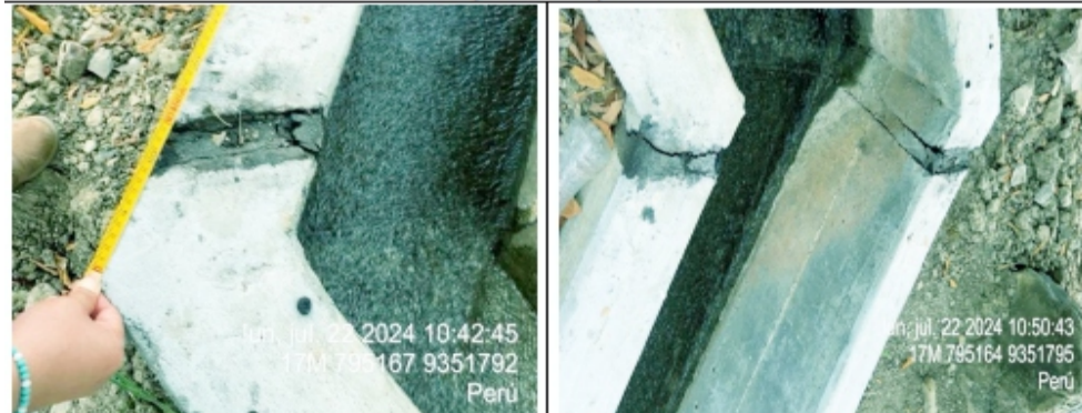
Se visualiza separación de muros de concreto de canal y juntas que carcon inadecuado relleno o sello asfáltico.
