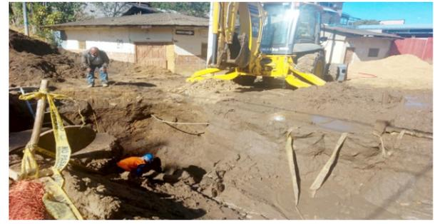
tin-San Martín", solicitan el cierre del reservorio de 2500 m<sup>3</sup> del Sistema Cachiayacu, con la finalidad de proceder a la reparación de una rotura en la línea de aducción de la tubería de 315 mm que afectaron con maquinaria pesada en la intersección de los jirones Perú y Elías Linares.
